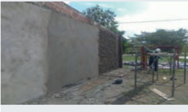
DURANTE LA OBRA
